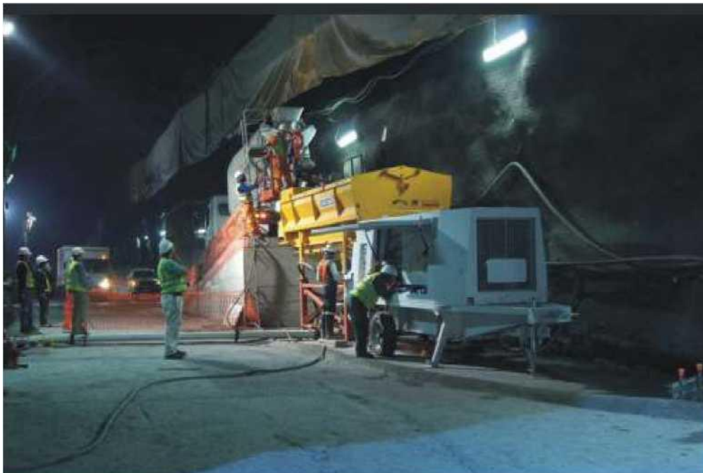
Bơm bê tông SP 4800 cho nhà máy thủy điện
