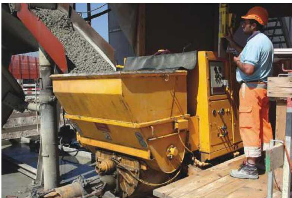
Bơm bê tông SP 3500 cho nhà cao tầng.
